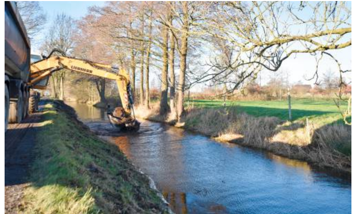
Auch die 3. Westerwieke wurde entschlammt.
