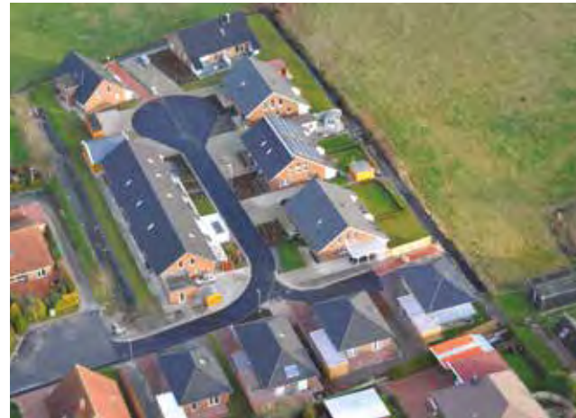
In der Sachsenstraße versorgt eine Erdwärmepumpe insgesamt 19 Wohneinheiten.
