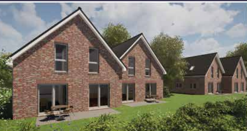
Zwei Doppelhäuser in Veenhusen
