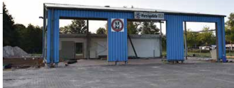
Auch das Gerippe des Feuerwehrhauses wird noch abgebrochen
