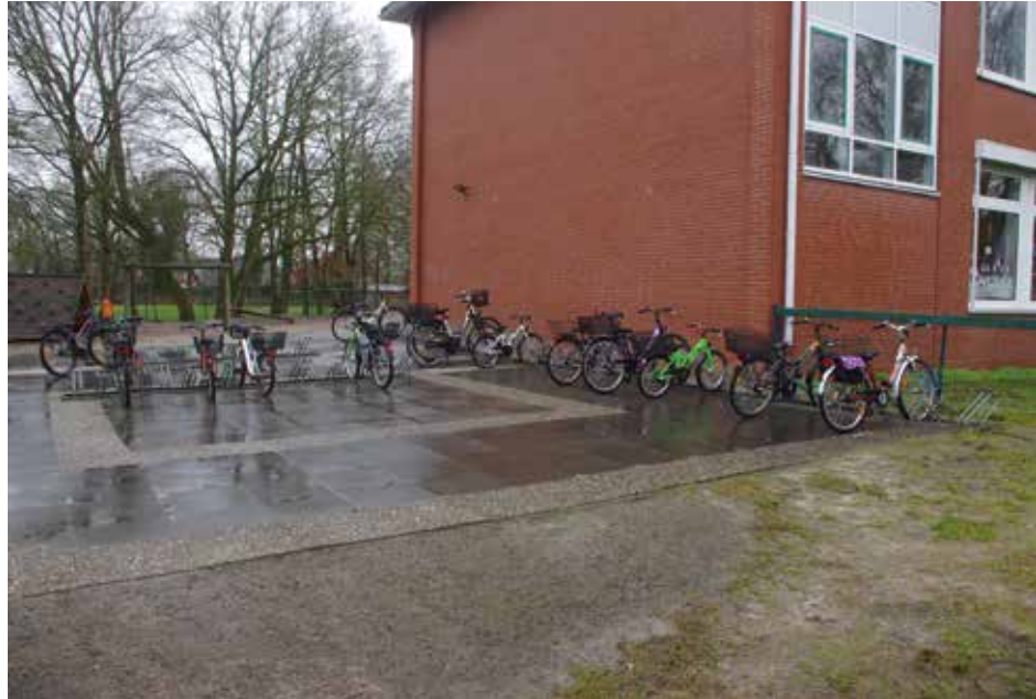
Fehlende Fahrradständer bei der Grundschule Hesel
