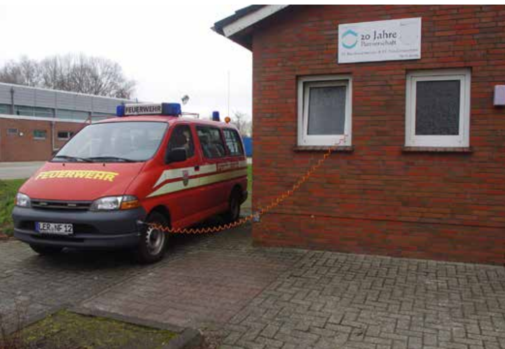
Fehlende Überdachung bei der Feuerwehr Neukamperfehn
